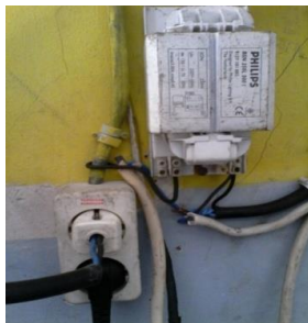
Gambar 4.3. Pemasangan stop kontak (sumber pribadi)
