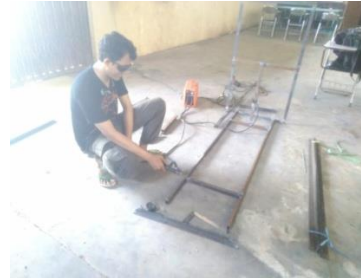
Gambar 3.2 Proses perakitan penyangga untuk sel surya
