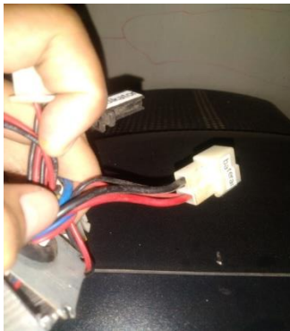
Gambar 3.15 kabel controller ke baterai (sumber : pribadi )
