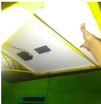
Gambar 3.11 pemasangan panel surya
